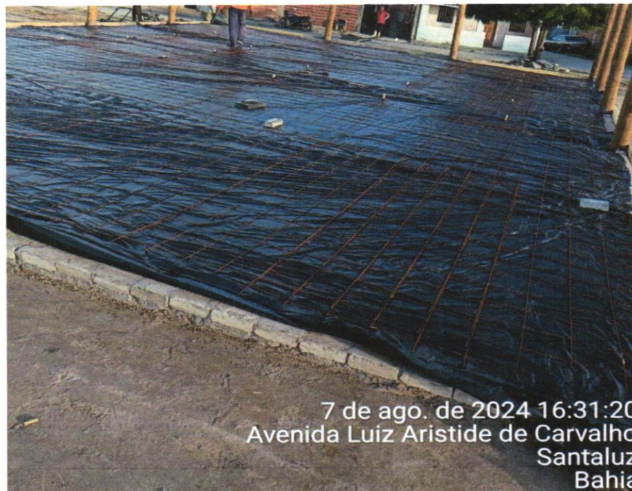
FOTO 08 – APLICAÇÃO DE LONA PLÁSTICA PARA EXECUÇÃO DE PAVIMENTOS DE CONCRETO AF_11/2017
