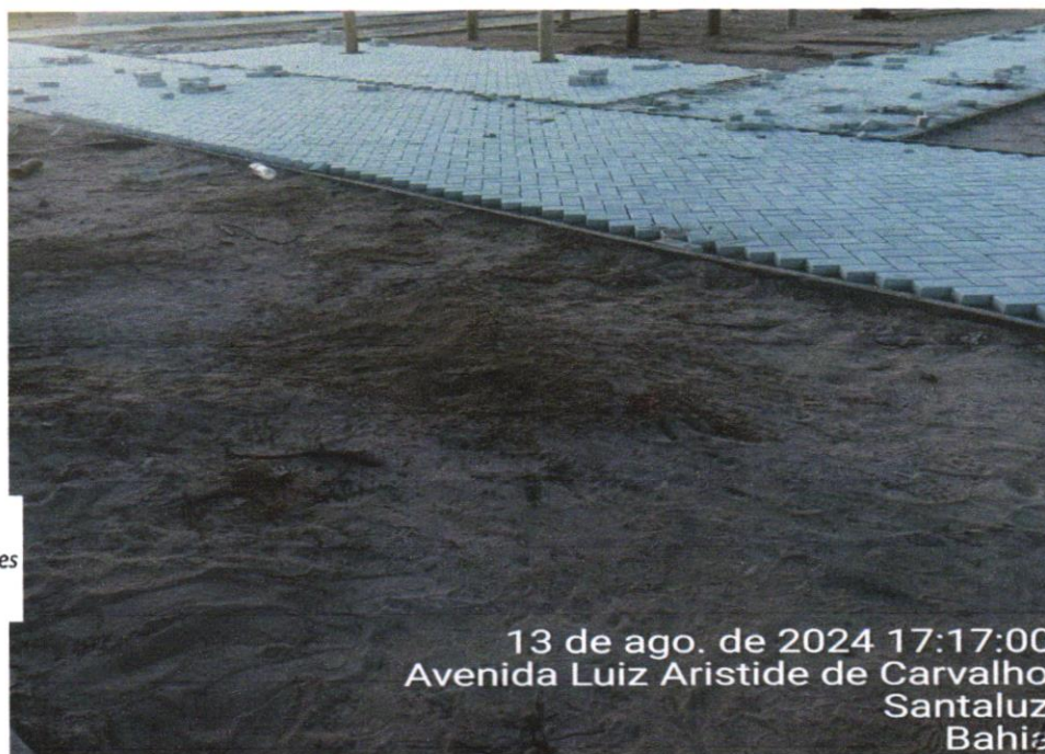
FOTO 04 - Pavimentação em bloco de concreto vibroprensado, intertravado, cor natural, 10x20cm, e=6cm, 46un/m 2 , NBR9781, Fck(min)=35MPa, sob coxim areia grossa compactada c/ placa vibratória, e(comp.)=6cm, rejuntado c/ areia fina.
