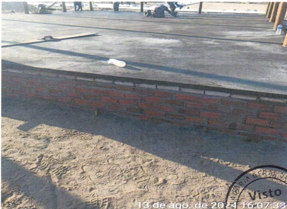
FOTO 10 – PISO EM CONCRETO 20 MPA PREPARO MECÂNICO, ESPESSURA 7CM. AF_09/2020
