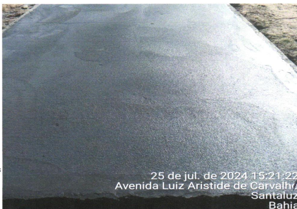
FOTO 02 – PAVIMENTAÇÃO EM CONCRETO, COM ESPESSURA DE 7 CM, COM ACABAMENTO FEITO UTILIZANDO ALISADORA DE CONCRETO (HELICOPTERO), INCLUIDO TELA DE AÇO SOLDADA
