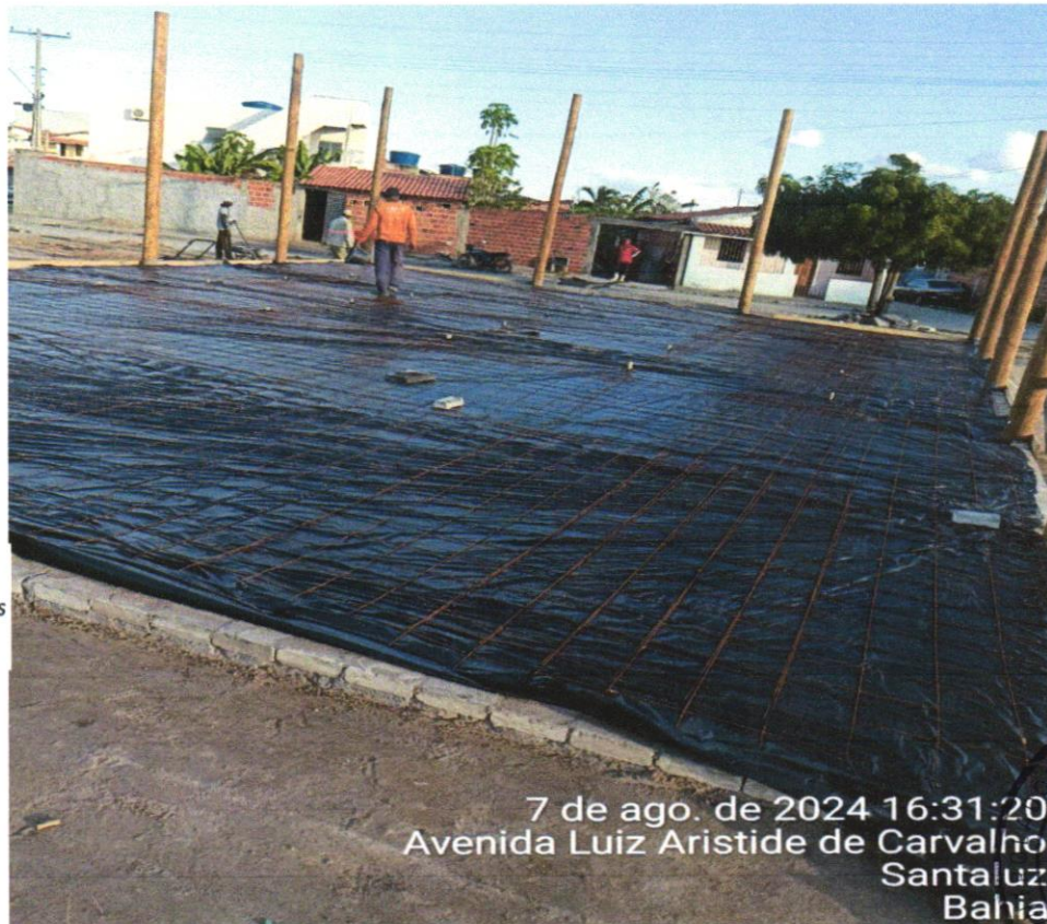
FOTO 06 – FORNECIMENTO DE PEÇA DE EUCALIPTO TRATADO, D= 16 A 19CM, L= 3,00 M (VIGAS)
